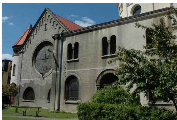
Fot. 28,29 Elewacja południowa kaplicy , widoczne tynki z pierwszej fazy budowy
