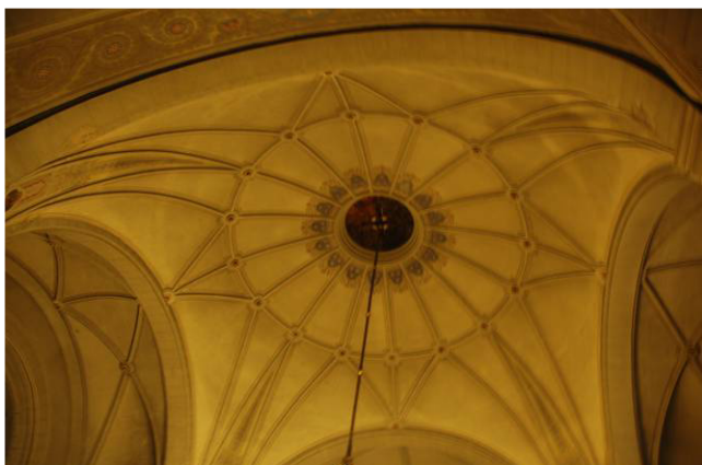
Fot.10,11 Kopuła od wnętrza kościoła z widocznymi ozdobnymi żebami, łękami i zwornikami tworzącymi jednolity rysunek gwieździsty
