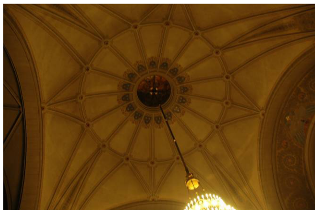
Fot.10,11 Kopuła od wnętrza kościoła z widocznymi ozdobnymi żebami, łękami i zwornikami tworzącymi jednolity rysunek gwieździsty
