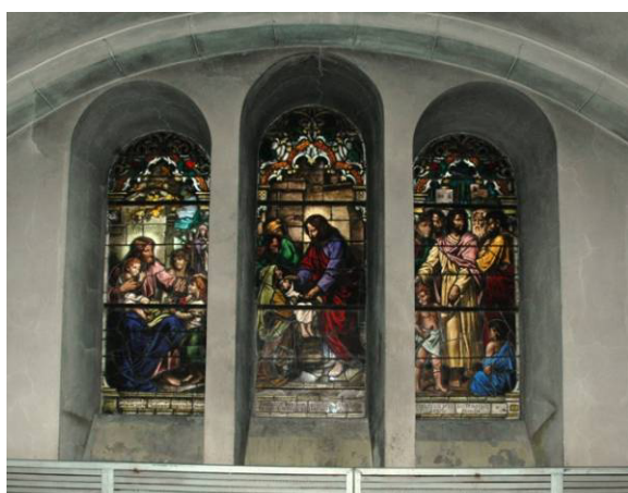
Fot. 42,43 Witraż z podziałem na trzy części. Od strony elewacji widoczne kraty do usunięcia, w miejscu krat wykonać zabezpieczenie z płyt poliwęglanu na stelażu stalowym. Należy zachować główny podział szprosów w nawiązaniu do witraży.
