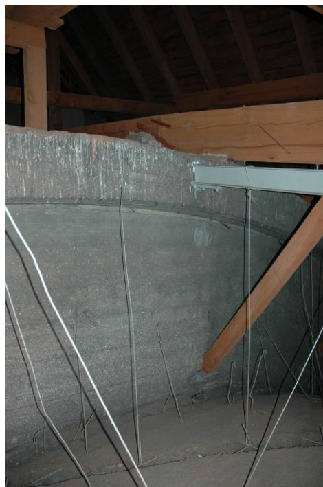
Fot. 16, 17 Sklepienia i łuki żelbetowe od strony zewnętrznej, czyli pomiędzy sklepieniem a więźbą dachową. Ciągna są luźno podwieszone do ścian zewnętrznych, łuków żelbetowych, belek stalowych lub elementów drewnianych, podczas wykonywanych prac remontowych należy naciągnąć w sposób umożliwiający ich właściwą pracę.
