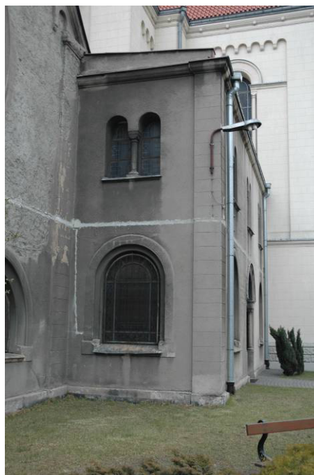
Fot. 34,35 Uszkodzony tynk nawy bocznej strony południowej z obrzutką cementowa
