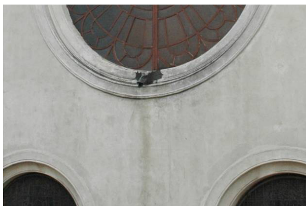
Fot. 8,9 Brakujący rzygacz od strony północnej zrekonstruować wg istniejącego od strony zachodniej.
