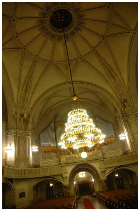
Fot. 14, 15 W centrum kopuły żyrandol, w typie korony składającej się z trzech poziomych kręgów, od góry o najmniejszej średnicy 200cm w części środkowej mierzący 300cm a od dołu największy o średnicy 400cm. Podwieszony łańcuchem z kablami do konstrukcji nad okulusem znajdującym się w górnej części kopuły.
