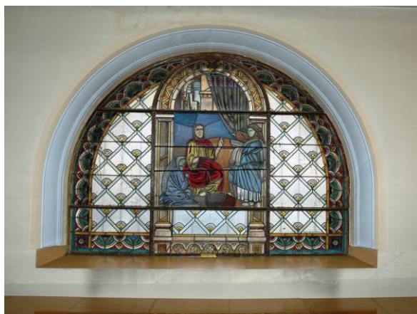
Fot. 43,44 Witraż w kształcie zbliżonym do półkola znajdujący się w kaplicy Mateusik. Zewnętrzne kraty do usunięcia, obróbki blacharskie do wymiany na nowe.
