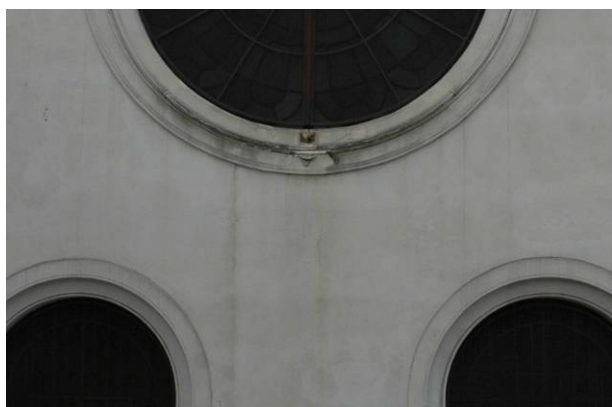
Fot. 8,9 Brakujący rzygacz od strony północnej zrekonstruować wg istniejącego od strony zachodniej.
