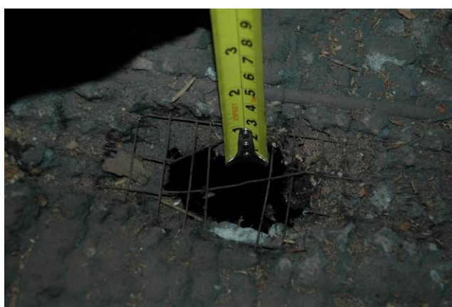
Fot. 22,23 Mechaniczne zniszczenie fragmentu sklepienia, widoczne są dwa otwory w kształcie zbliżonym do elips o długości 4cm i 6cm
