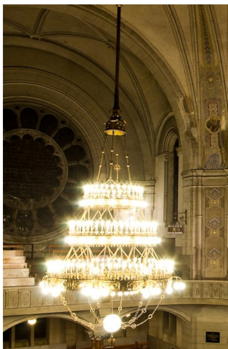
Fot. 14, 15 W centrum kopuły żyrandol, w typie korony składającej się z trzech poziomych kręgów, od góry o najmniejszej średnicy 200cm w części środkowej mierzący 300cm a od dołu największy o średnicy 400cm. Podwieszony łańcuchem z kablami do konstrukcji nad okulusem znajdującym się w górnej części kopuły.
