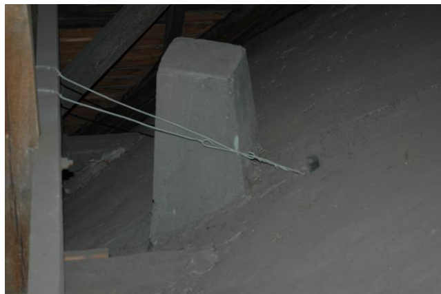
Fot. 20,21 Zbrojenie kopuły głównej. Widoczne gładkie pręty w miejscu występowania zworników, do których podwieszone są szyszki. Nie wszystkie elementy betonowej podbudowy (widoczne na fot. 21) zostały wykorzystane do celów konstrukcyjnych. Część pozostała nie użyta
