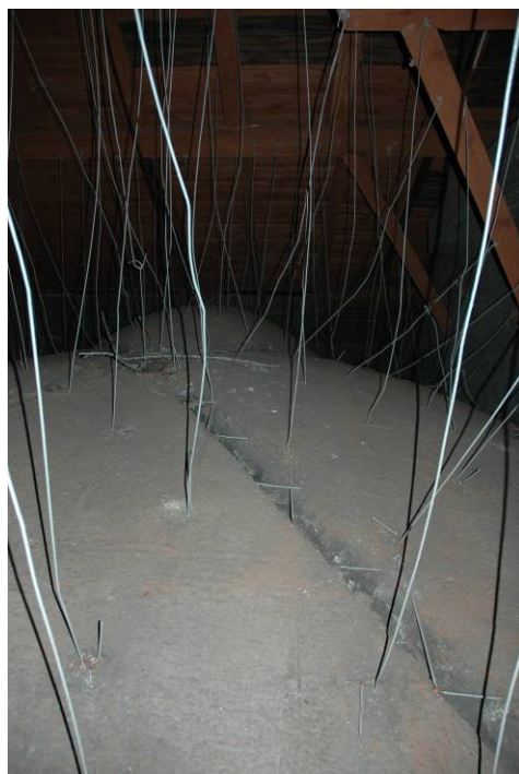
Fot. 16, 17 Sklepienia i łuki żelbetowe od strony zewnętrznej, czyli pomiędzy sklepieniem a więźbą dachową. Ciągna są luźno podwieszone do ścian zewnętrznych, łuków żelbetowych, belek stalowych lub elementów drewnianych, podczas wykonywanych prac remontowych należy naciągnąć w sposób umożliwiający ich właściwą pracę.
