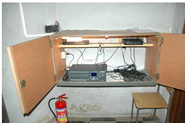
Fot. 52,53 Wzmacniacze należy zlokalizować w pomieszczeniu w którym obecnie znajduje się sprzęt nagłaśniający. W razie potrzeby skrzynkę na sprzęt przebudować lub wykonać nową.
