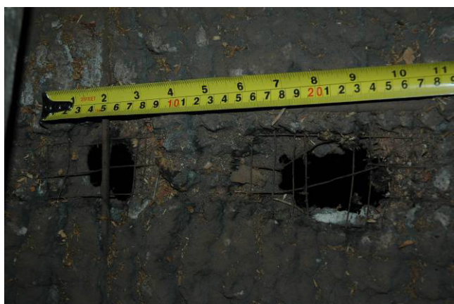
Fot. 22,23 Mechaniczne zniszczenie fragmentu sklepienia, widoczne są dwa otwory w kształcie zbliżonym do elips o długości 4cm i 6cm
