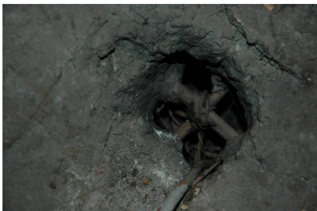
Fot. 20,21 Zbrojenie kopuły głównej. Widoczne gładkie pręty w miejscu występowania zworników, do których podwieszone są szyszki. Nie wszystkie elementy betonowej podbudowy (widoczne na fot. 21) zostały wykorzystane do celów konstrukcyjnych. Część pozostała nie użyta
