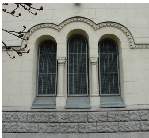
Fot. 42,43 Witraż z podziałem na trzy części. Od strony elewacji widoczne kraty do usunięcia, w miejscu krat wykonać zabezpieczenie z płyt poliwęglanu na stelażu stalowym. Należy zachować główny podział szprosów w nawiązaniu do witraży.
