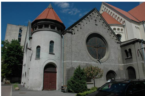
Fot. 28,29 Elewacja południowa kaplicy , widoczne tynki z pierwszej fazy budowy
