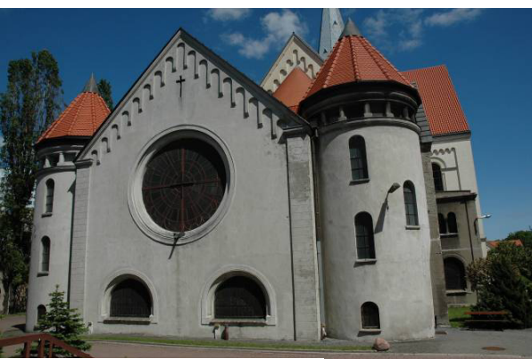
Fot. 30,31 Elewacja zachodnia kaplicy , widoczne wtórne tynki cementowe
