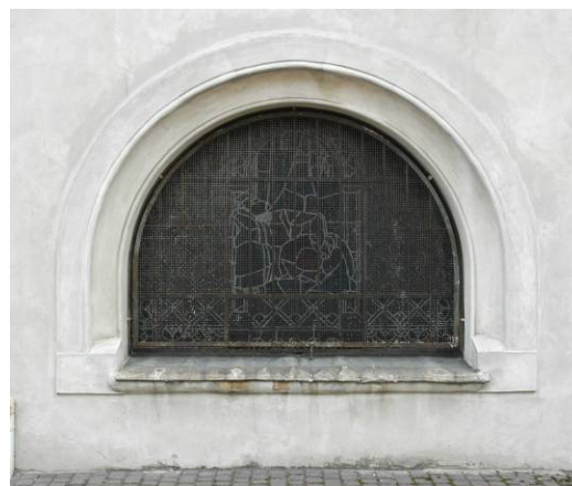
Fot. 43,44 Witraż w kształcie zbliżonym do półkola znajdujący się w kaplicy Mateusik. Zewnętrzne kraty do usunięcia, obróbki blacharskie do wymiany na nowe.
