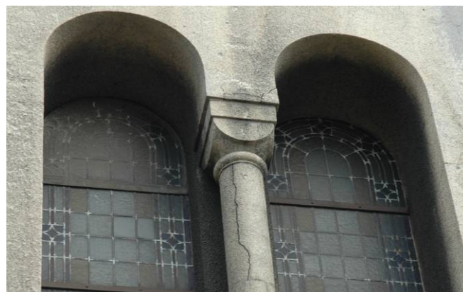
Fot. 36,37 Widoczne bruzdy po montowanych wcześniej instalacjach elektrycznych oraz rysy i pęknięcia ozdobnej kolumny znajdującej się pomiędzy dwoma witrażami.
